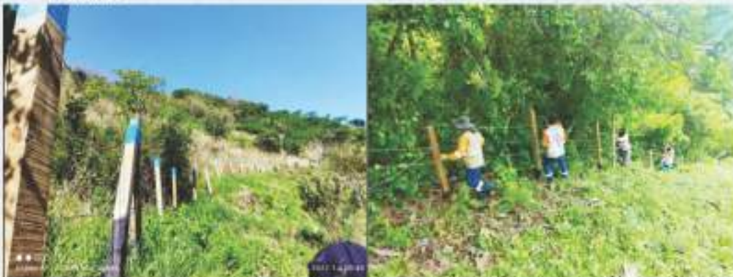
Fotografía 2. Ejecución de cerramientos perimetrales
