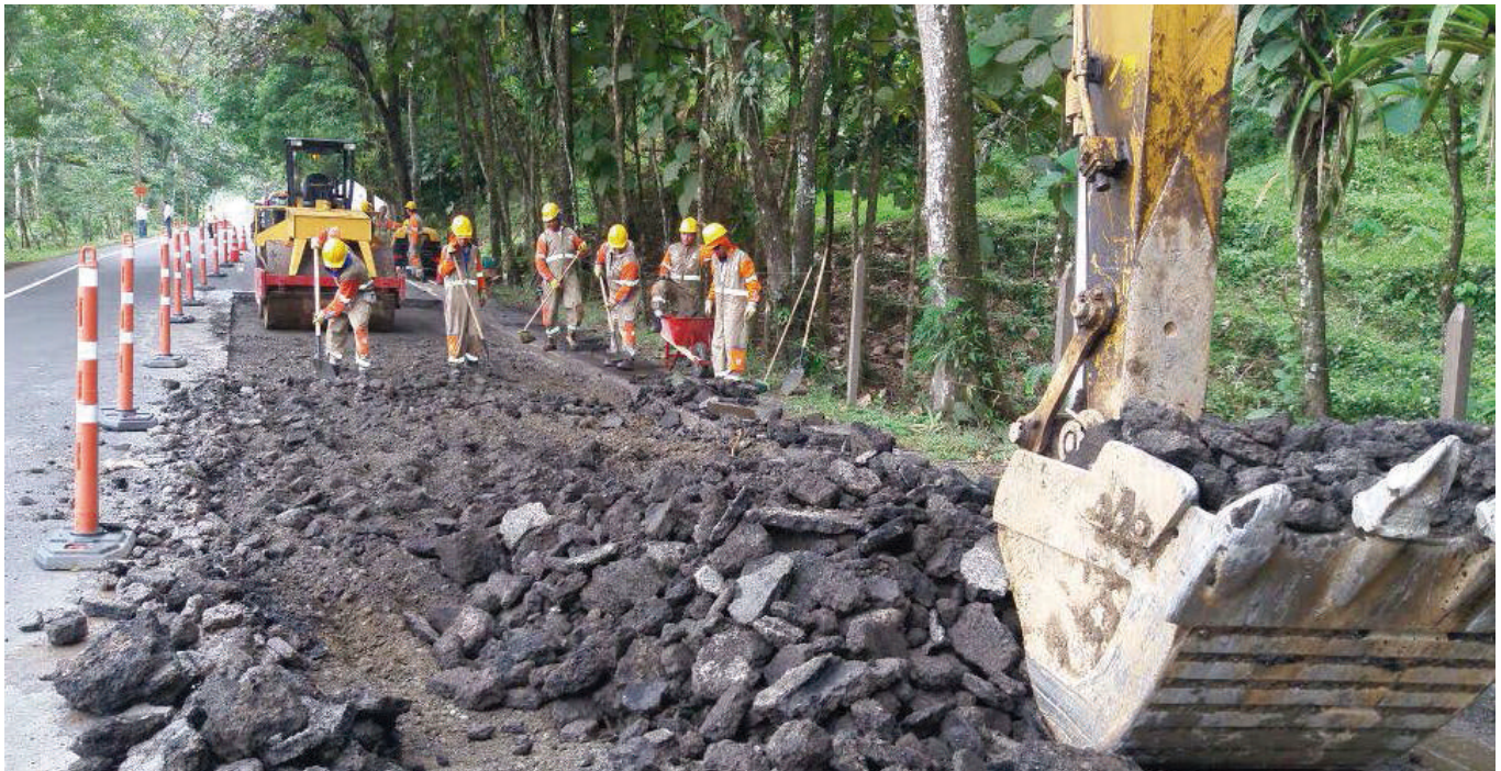
TRABAJOS DE REHABILITACIÓN EN LA UF 5-MUTATÁ-EL TIGRE.
